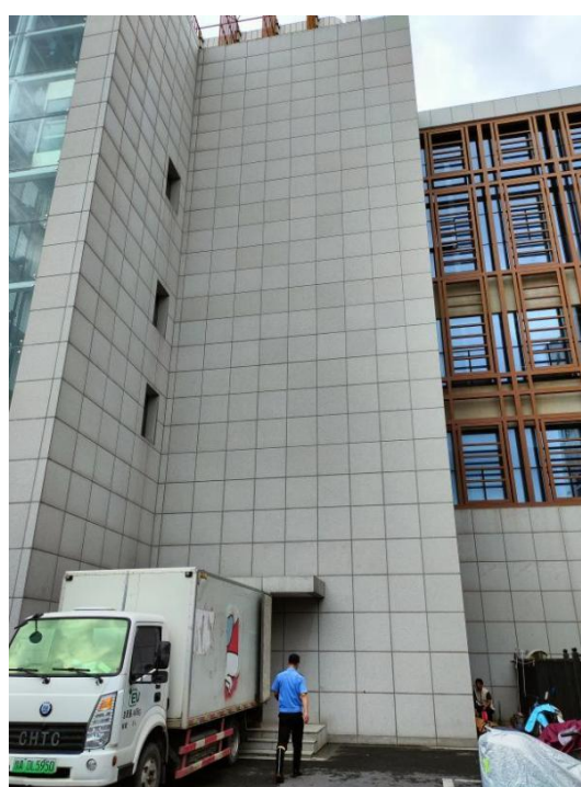
四号楼南疏散步梯
