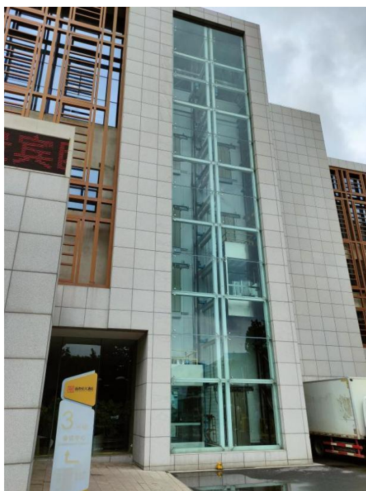
四号楼观光电梯
